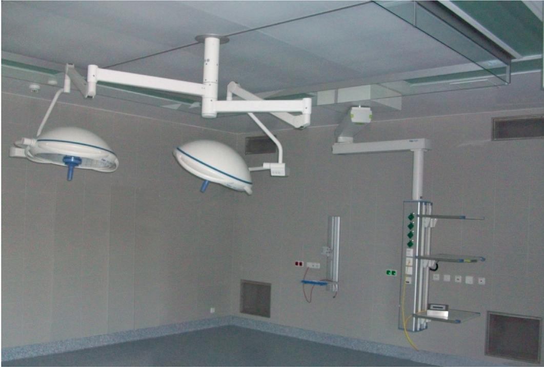
Abbildung 1: Operationssaal der Klasse 1a nach DIN 1946-4:2018-09
